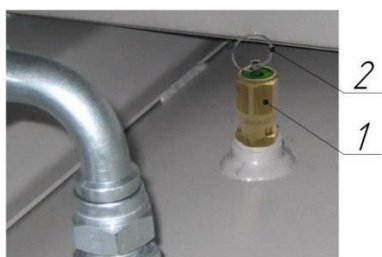
Рисунок 8 – Клапан предохранительный пружинного типа
